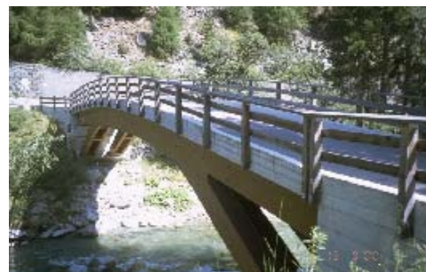
Crestawaldbrücke zu Militärdepot bei Sufers (CH)
