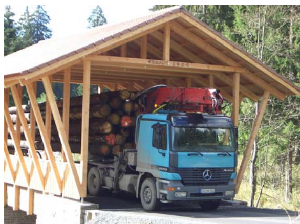
Forstwegbrücke über den Brunnenbach (D)
