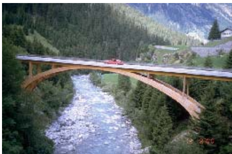
Bild 1 Straßenbrücke über den Averser Rhein bei Innerferrera (CH)
