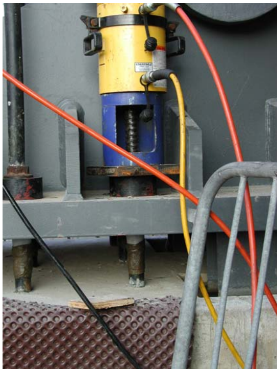
Bild 1: „Vorspannung Ankerplatte“
