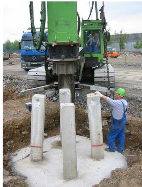
Bild 17 Dynamische Probelastungen an Spannbeton-Fertigteilrammpfählen einer Pfahlgruppe
